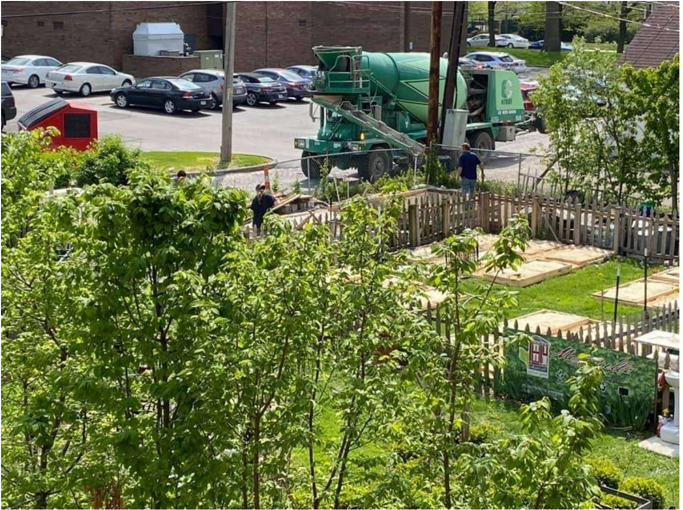
Pouring the slabs
